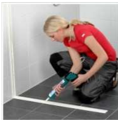
Krok 4 - naneste lepidlo na obě strany krátkého svislého profilu.
