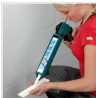
Krok 6 - Naneste lepidlo Block Lock na dlouhý vodorovný profil, který potom položte na první řadu luxfer.
