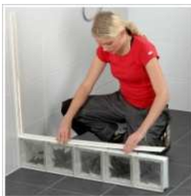
Krok 8 - Stěna nemusí být prvních 24 hodin po dokončení zcela pevná. Sprchu sice můžete používat již první den po dokončení, ale lepidlo zcela zatvrdne až po cca 3 týdnech.
